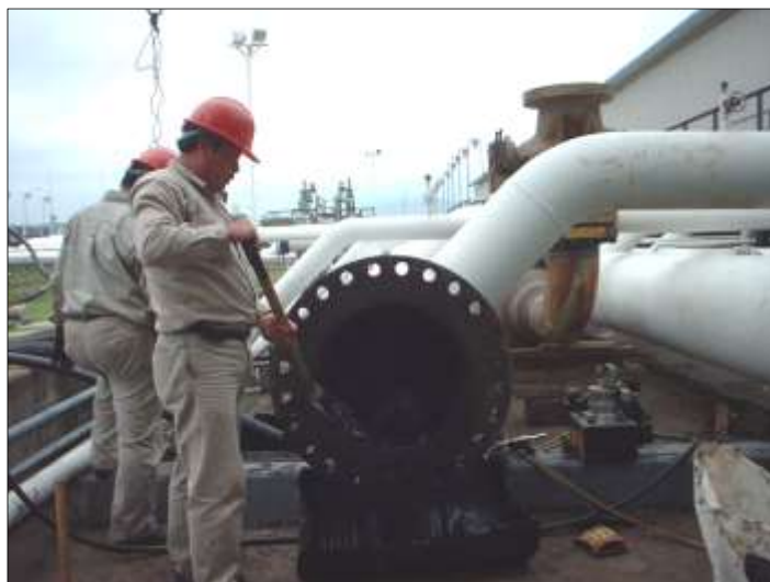
Figura 4.6.4. Limpieza general de instalaciones
