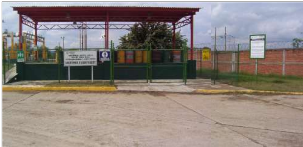
Figura 4.9.1. Vista frontal del Almacén Temporal de la CAB Poza Rica.
