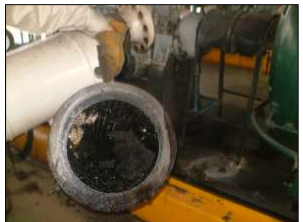
Figura 4.6.2. Mantenimiento a válvulas de seccionamiento
