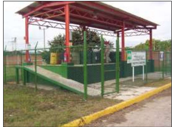
Figura 4.9.4. Área de carga y descarga.
