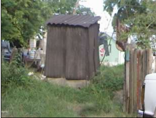
Imagen 6.- Letrina construida a base de lámina y cartón ubicada en la calle Hidalgo.
