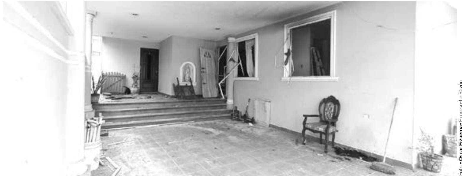
LA EXPLOSIÓN ocurrió el pasado 2 de febrero en la Ampliación de la Unidad Nacional.
