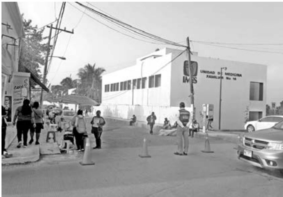
SE REGISTRÓ una fuga y fisura en una válvula de gas.
