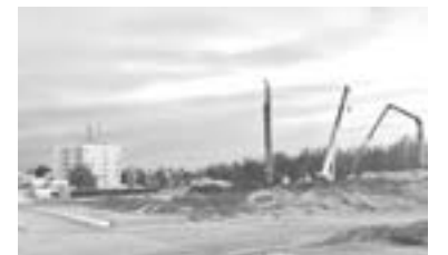
INICIÓ LA CONSTRUCCIÓN de condominios en Miramar
