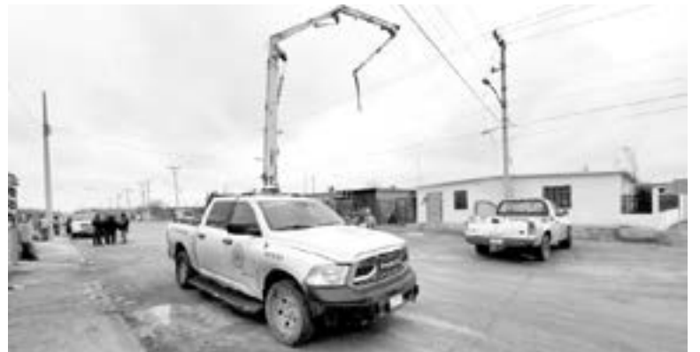
SE ENCONTRABA vertiendo cemento a una azotea
