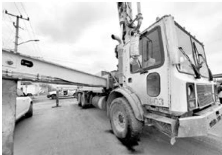
EL LESIONADO sufrió una fuerte descarga eléctrica al operar la grúa
