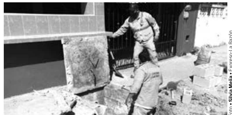
MEJORA EL SISTEMA DE DRENAJE y alcantarillado en la zona de Monte Alto.
