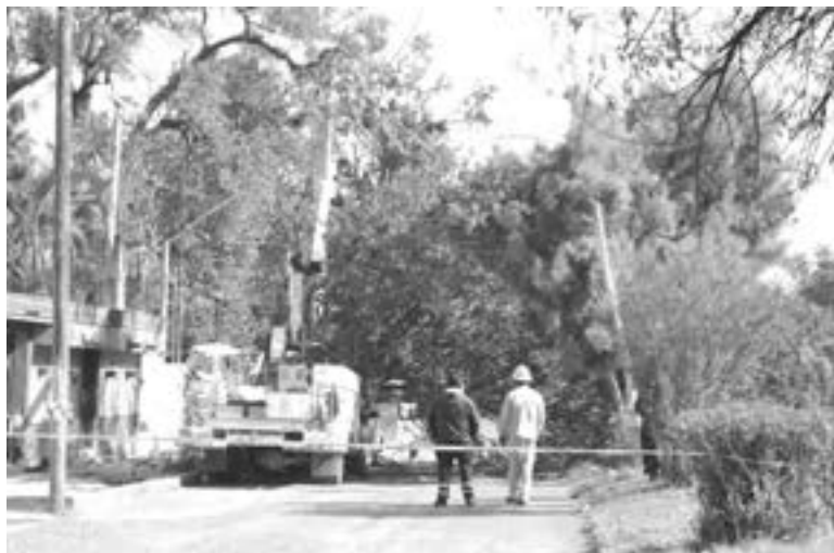
PERSONAL de la CFE cortó el suministro eléctrico.
