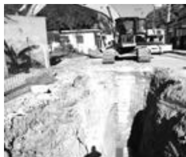
LOS TRABAJOS se realizan en la colonia Las Brisas.
