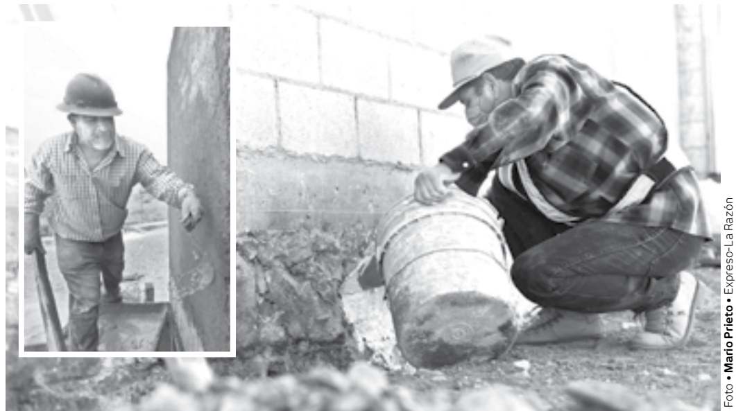
EN LA BANCA DEL DESEMPLEO trabajadores de la construcción.
