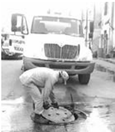
SOLUCIONAN AZOLVAMIENTOS en tuberías del fraccionamiento Paseo Real,
