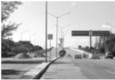
MÁS DE TRES MIL FAMILIAS afectadas por paso a desnivel cerrado.
