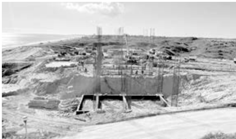
LAS OBRAS continuarán ampliándose para 2022.
