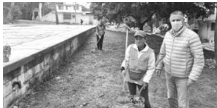
EL ALCALDE Chucho Nader supervisó los trabajos de limpieza y mejoramiento urbano en la colonia Otomí.
