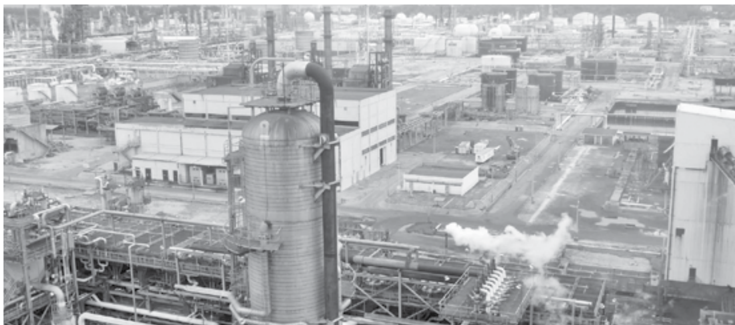
EN LA REFINERÍA ya realizan mantenimiento.
