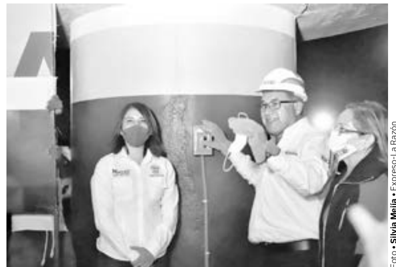
INAUGURA ARMANDO Martínez moderna red de alumbrado en el sector Monte Alto.
