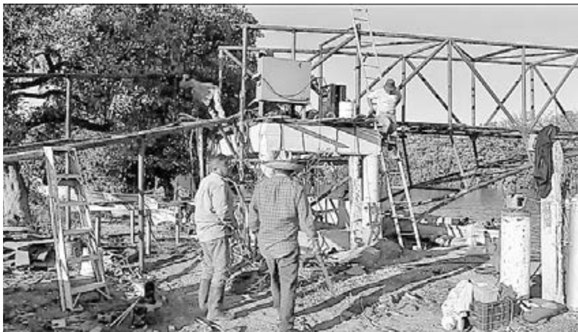
TRABAJADORES REALIZAN la reparación del puente 'Mata de Chávez'.
