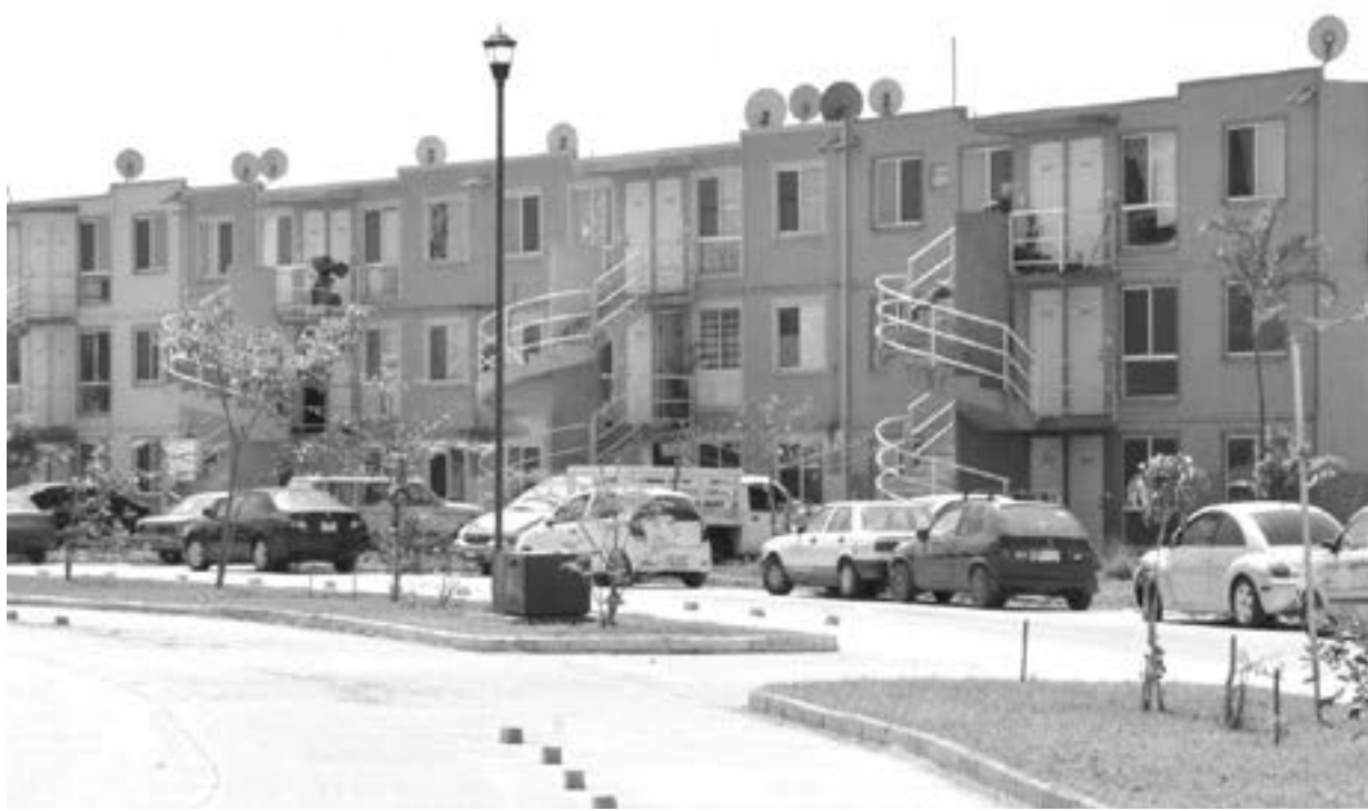
LAS VIVIENDAS del fraccionamiento fueron vendidas como alta plusvalía.
