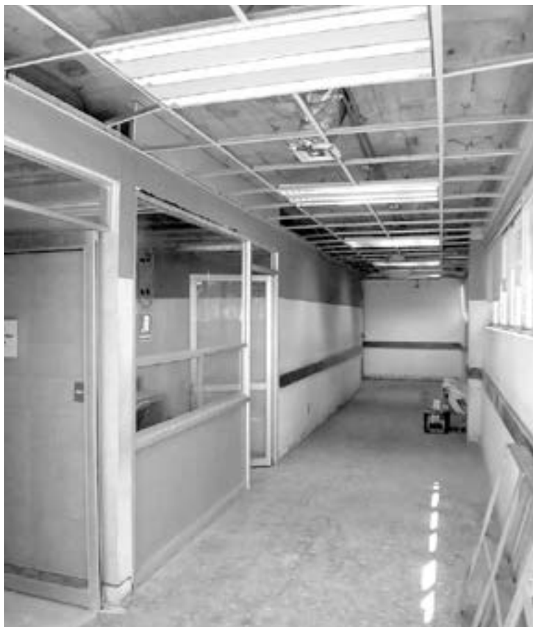
LAS REPARACIONES comenzaron por el área de Urgencias.
