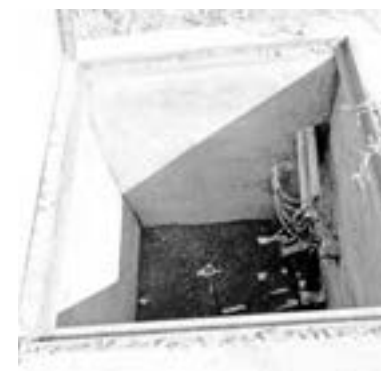
ABRIERON el registro para poder cortar los cables.
