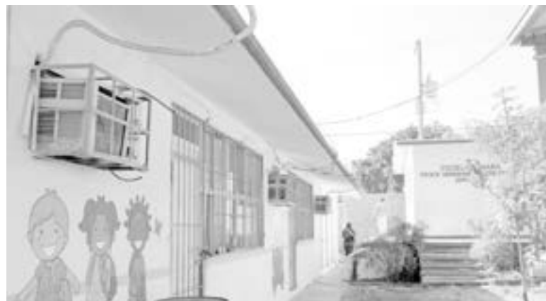
LOS LADRONES se llevaron los cables que alimentan a los aires acondicionados
