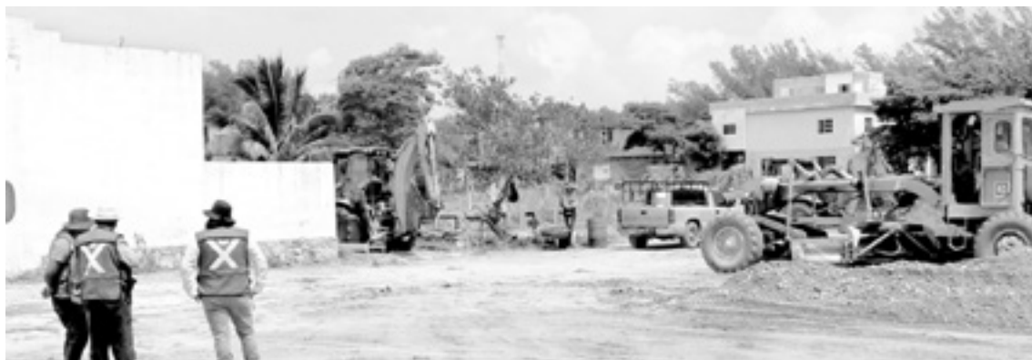
APROXIMADAMENTE SERÁN 8 meses los que dure la construcción.
