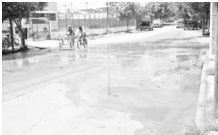
FUGAS POR DOQUIER afectan colonias, pagos no se ven reflejados en mejoras.
