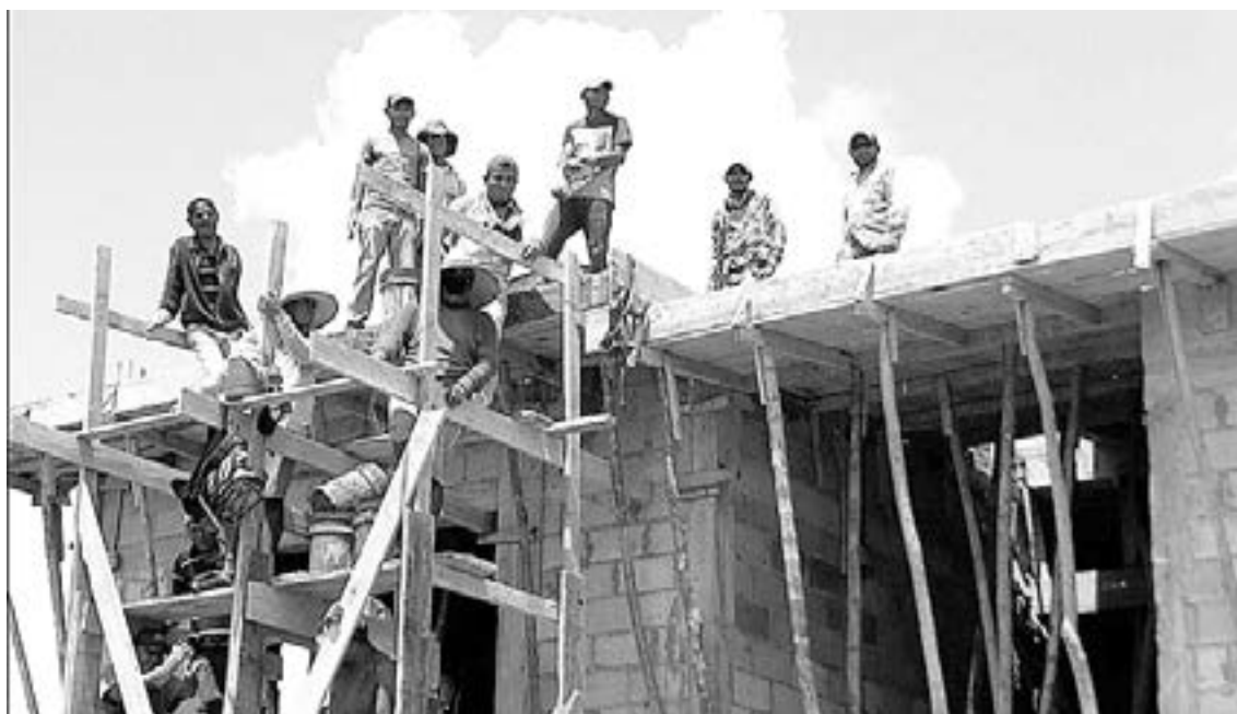
DIFÍCIL SITUACIÓN atraviesan albañiles en Pueblo Viejo.
