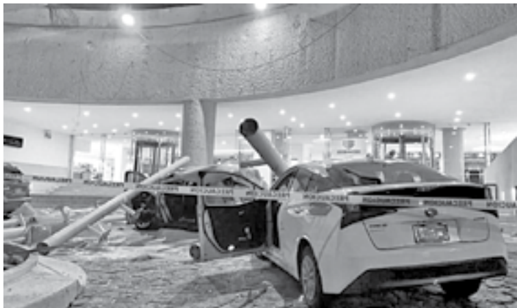
DAÑOS REGISTRADOS en Acapulco
