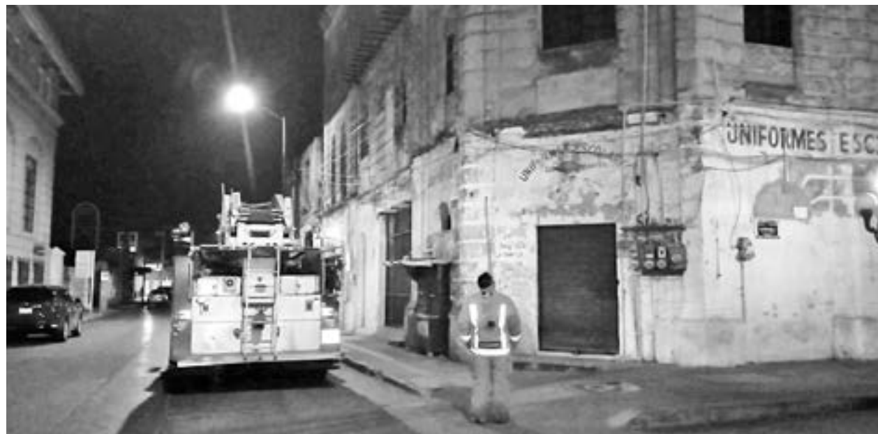
LA PLANTA alta del edificio se encuentra abandonada.
