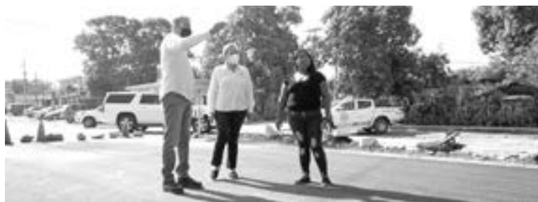
SUPERVISA ALCALDESA pavimentación asfáltica de la Avenida Miramar.
