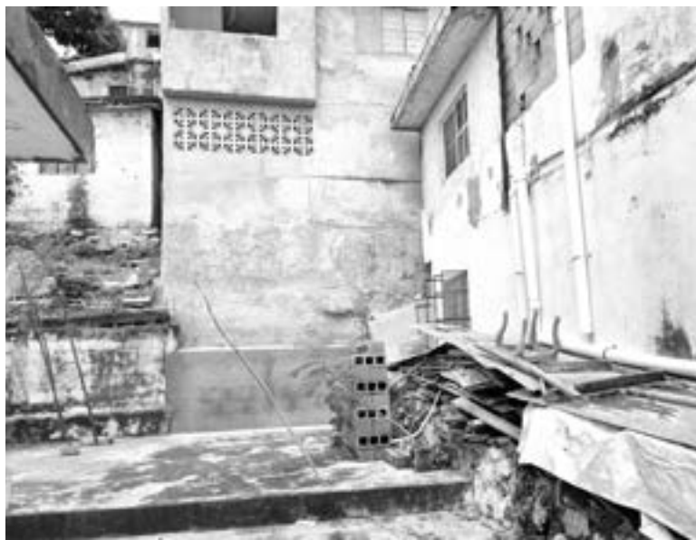
EN ZONAS de deslave reforzaron muros.
