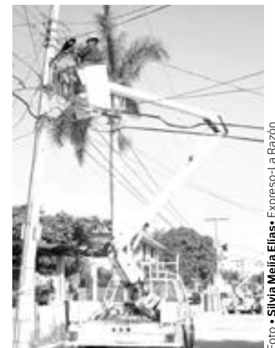
SE COLOCARON 23 modernas luminarias, sustituyendo 2 mil 427 lámparas de alumbrado público.
