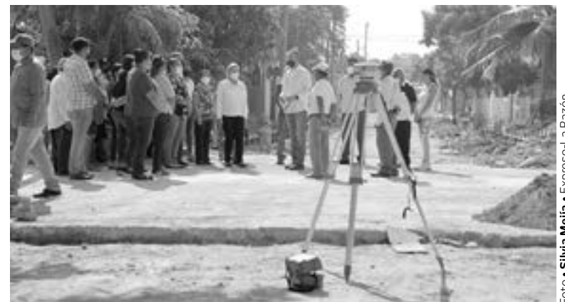
ALMA LAURA, alcaldesa de Altamira supervisa los trabajos.
