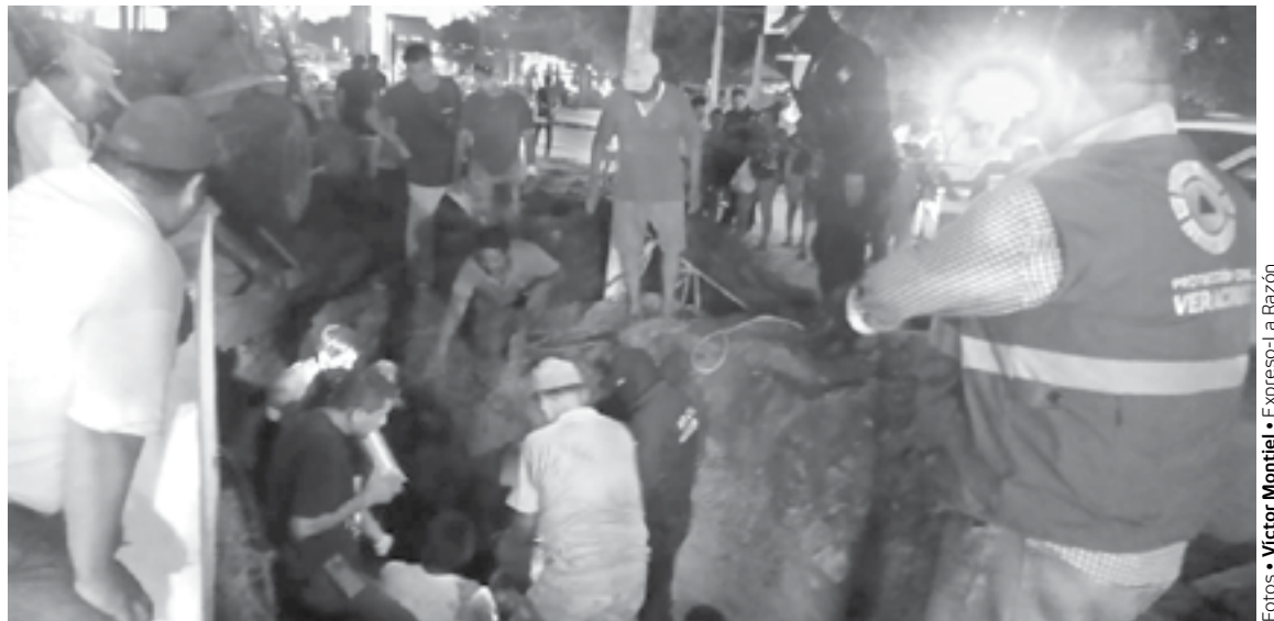
PROTECCIÓN CIVIL y personal de CAEV realizaron las labores de rescate.
