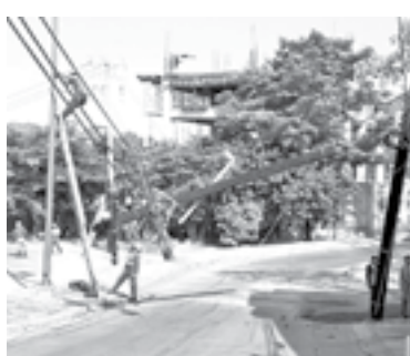
PERSONAL DE CFE realizó las labores necesarias para retirar el poste.
