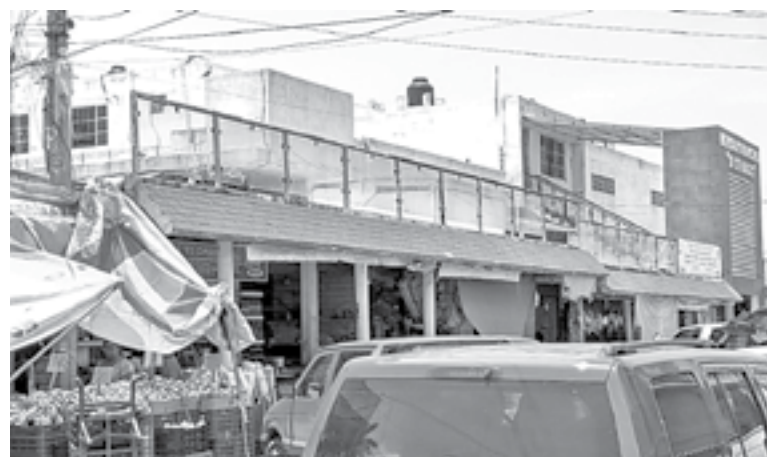
HACEN TRABAJOS de mantenimiento en mercado municipal
