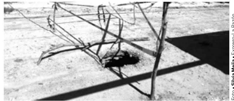
VECINOS AFIRMARON que fue un camión de carga el que ocasionó el hoyanco.
