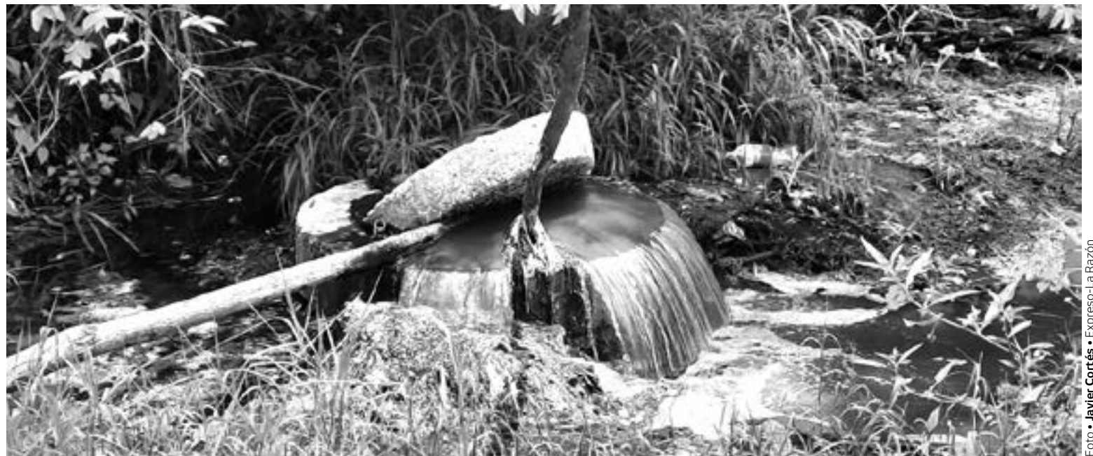
PESTILENTES OLORES son los que se desprenden de esta fuga.
