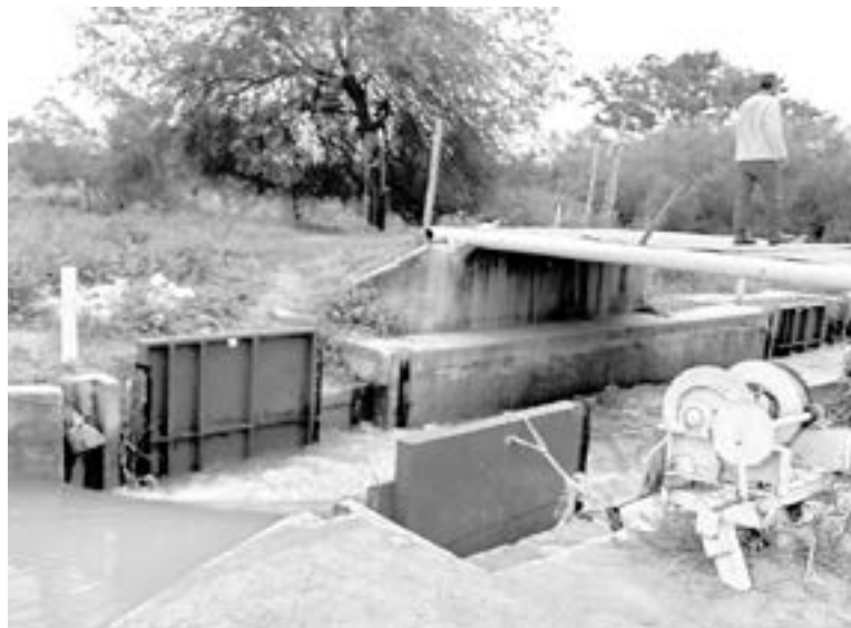
EL PROBLEMA continúa pero ahora por la mala decisión de colocar la compuerta al revés.
