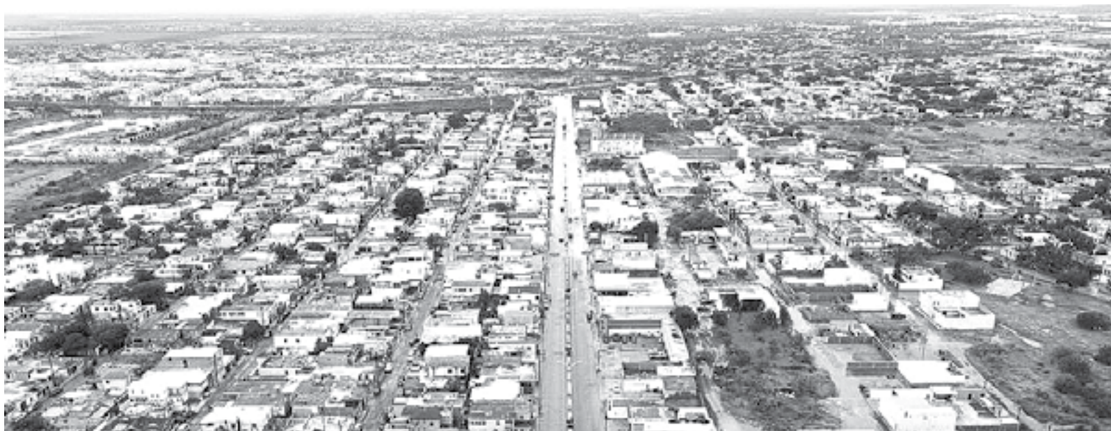
UNA PANORÁMICA de las afectaciones
