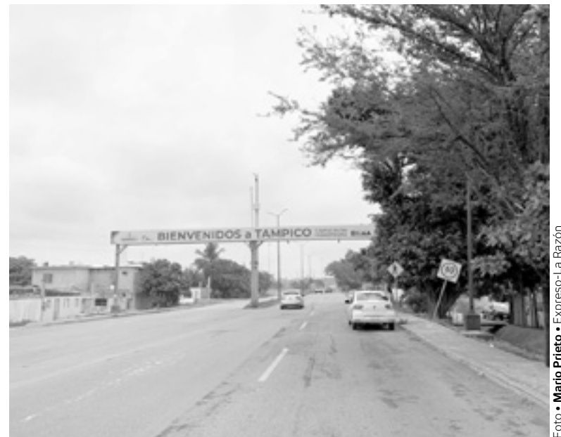
EN EL PUENTE El Moralillo sería construido un filtro de seguridad.
