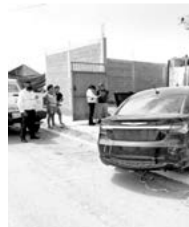
TUMBÓ gran parte del muro y una hoja del portón.
