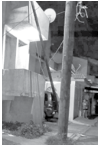
EL POSTE quedó inclinado en el muro de un edificio de departamentos.
