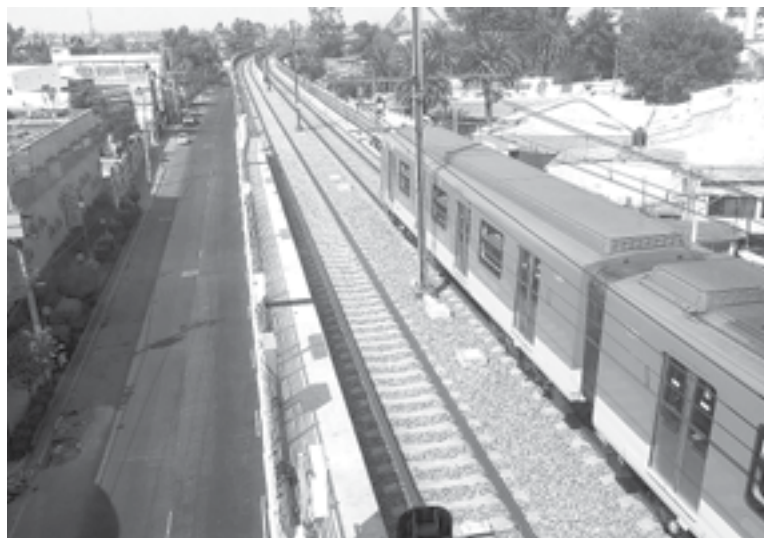
VIADUCTO ELEVADO de Línea 12 será difícil de volver a utilizar.
