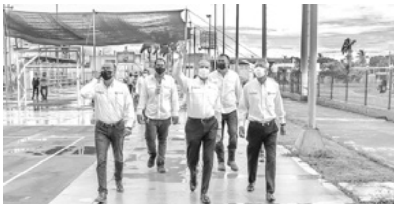
ADRIÁN OSEGUERA Kernion realizó una supervisión de los trabajos en las canchas de frontón.
