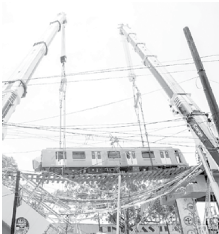
APUNTA dictamen a fallas en soldadura, pernos...
