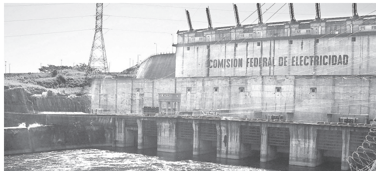
LA LEY dicta que en época de estiaje debe restringirse la generación eléctrica en presas.
