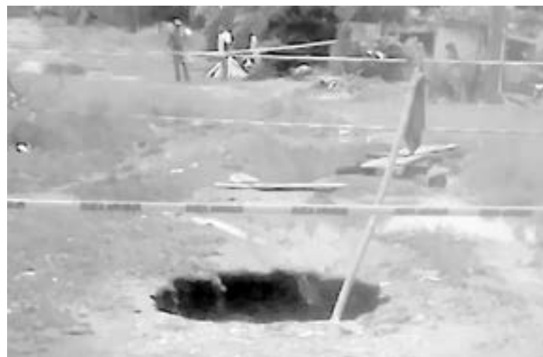
VECINOS DIERON aviso a Protección Civil sobre el socavón que se produjo en la zona.
